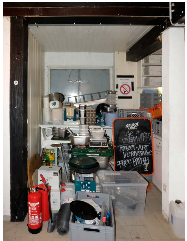
R 6.02 A/B/C: Lagermische mit Holzstütze
