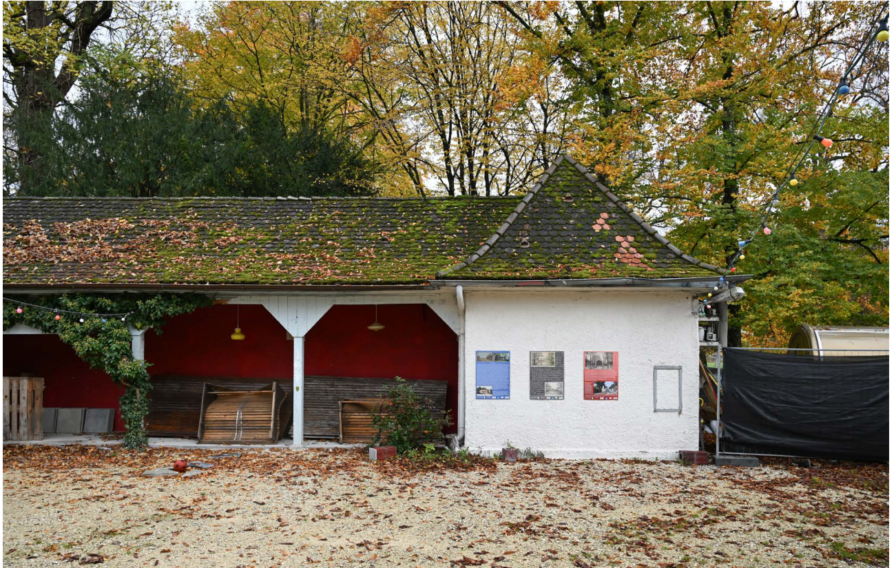
R 8.02 D: Blick von außen
