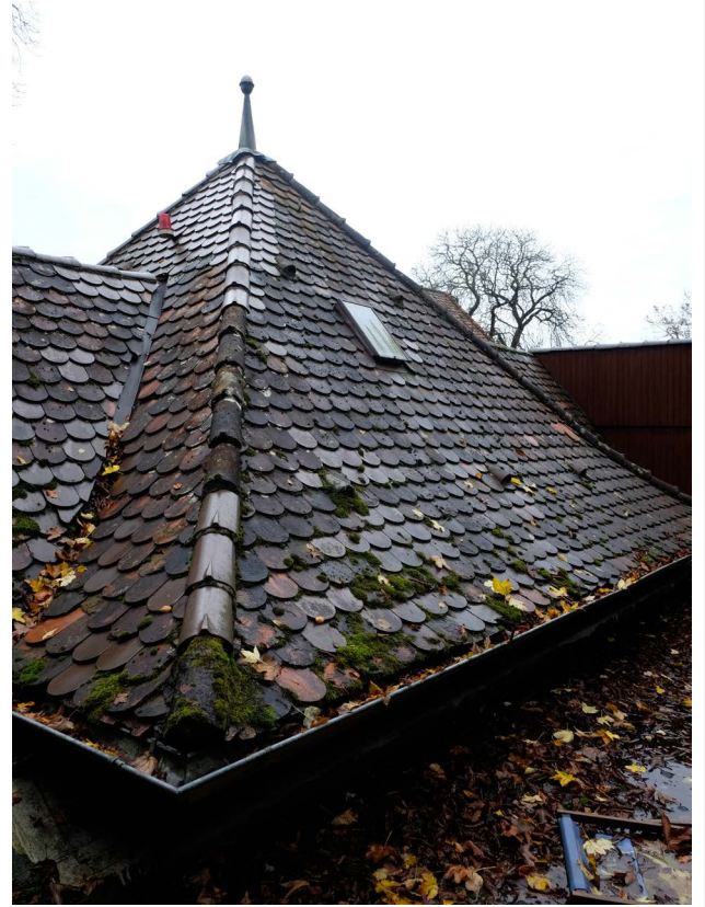
R 7.07 C: Blick auf das Walmdach
