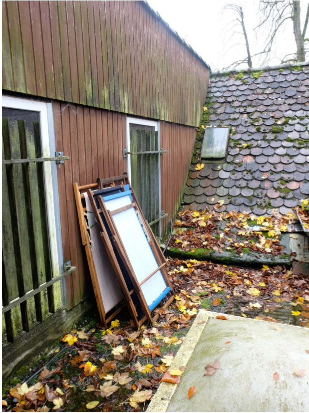
R 7.07 B/C: Blick auf Dachanschluss
