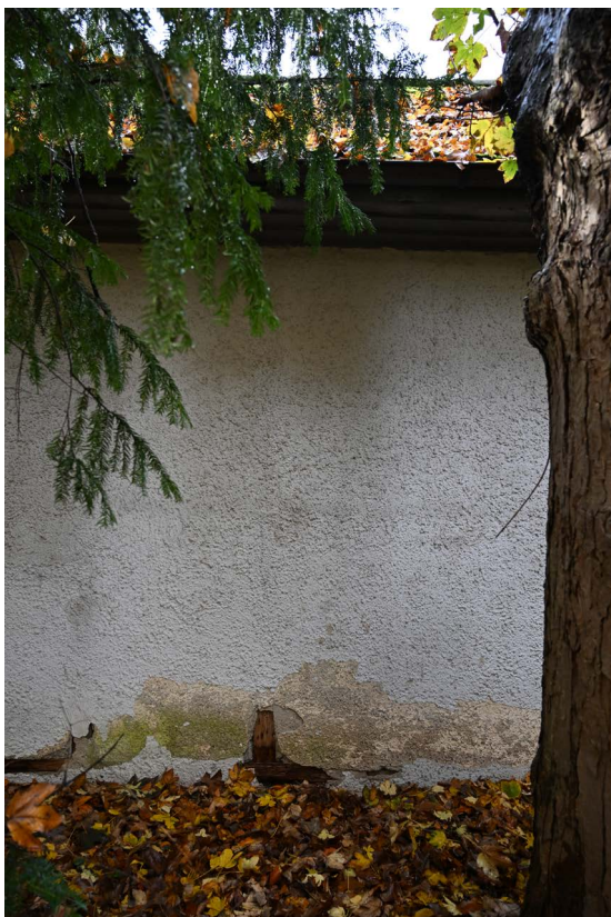
R 8.02 B: Blick von außen
